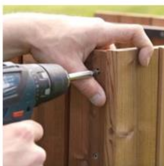
Joonis 20: Tarnitavate osade ulatus, seinte krüvimine kokku, kate tõmbamine
