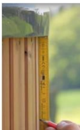
Joonis 18: Joogiriuli paigaldamise osade ulatus, ülemise serva paigaldusasendi märkimine, riuliplaadi positsioneerimine
