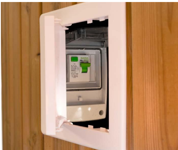
Joonis 23: FI kaitsme asukoht ja illustratsioon (sisse lülitatud)
