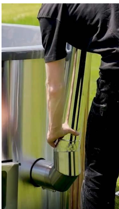
Joonis 16: Alumise toru kokkupanek
