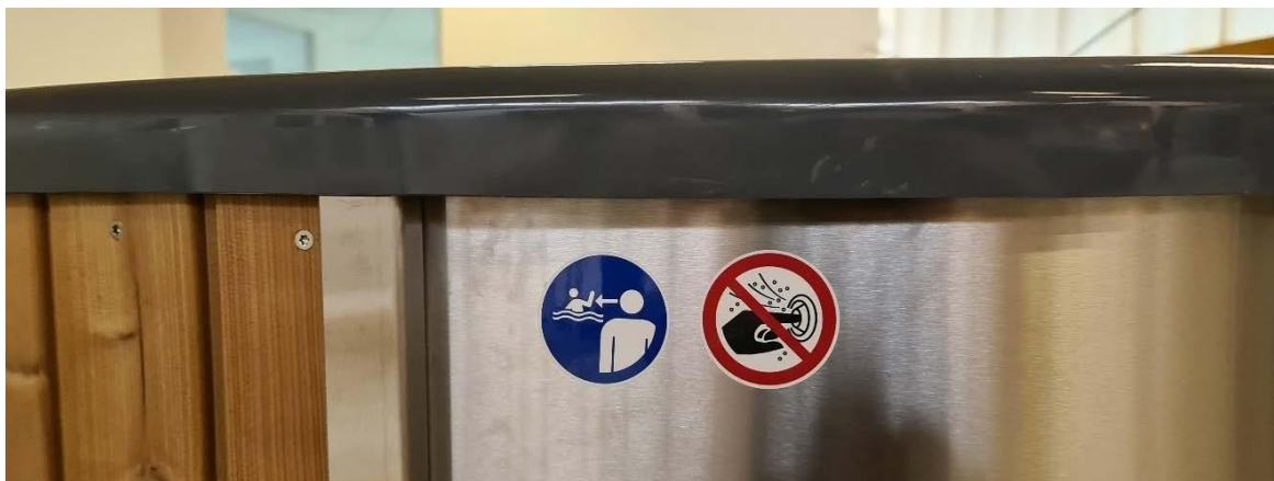
Joonis 2: Kümblustünni külge ei ole kinnitatud hoiatust laste järelevalve ja sõrmede pihustitesse torkamise keelamise kohta.
