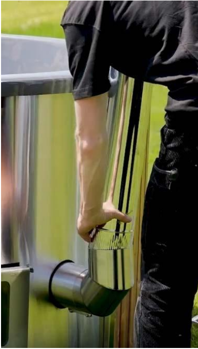
Kuva 16: Alemman putken kokoaminen
