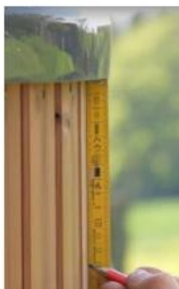
Kuva 18: Juomahyllyn asennusosien laajuus, yläreunan asennusasennon merkintä, hyllylevyn sijoittaminen
